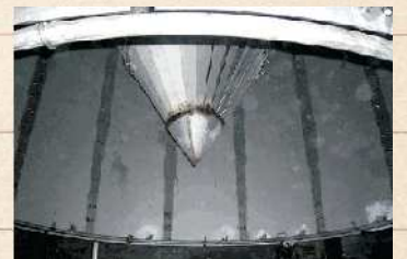
▲スクラパー内部改修工事
